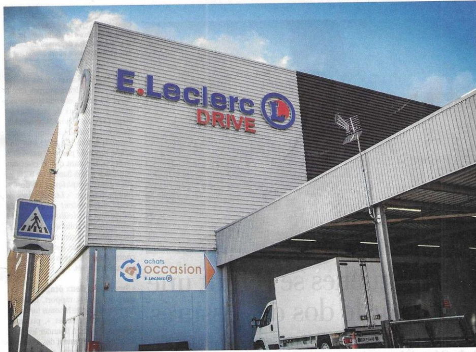
E.Leclerc Drive à Roques (Haute-Garonne). L'enseigne, qui a dépensé 5 à 6 milliards dans sa logistique en un peu plus de quinze ans, compte aujourd'hui davantage de drives (785) que d'hypermarchés (700) et séduit déjà près de 5 millions de clients.
